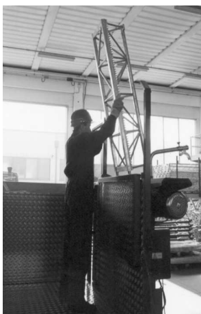
Fig. 15 Montaje de la columna
