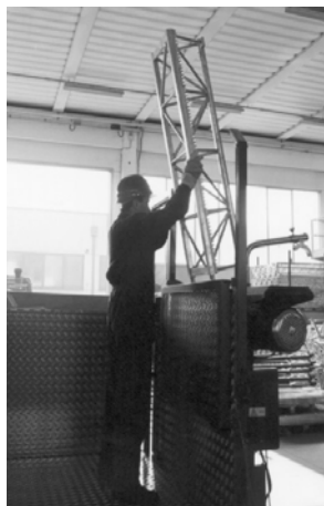
Fig. 15 Montaje de la columna
