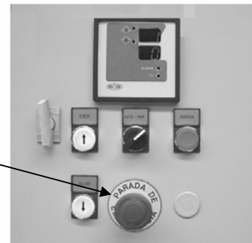
Fig. 4 Botón rojo de emergencia en Selector de Pisos (opcional) o Botonera
